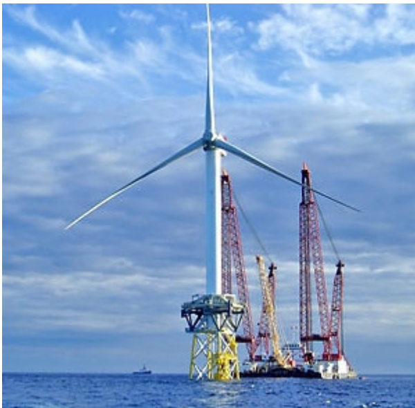
Figur 4-3 Fackverksfundament vid "Beatrice" projektet i Skotska Nordsjön, grundläggningsdjup 44 m.
