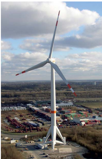
Figur 4-2 5 MW M500 från Multibrid i Bremerhaven med en innovativ tripod lösning.
