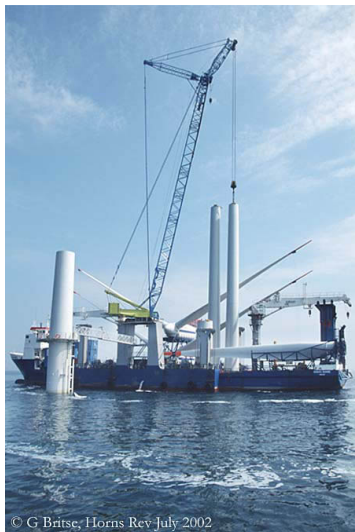
Figur 4-1 Monopiles från Horns rev.
