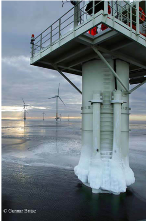
Figur 7-2 Nedising på stege.
