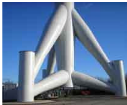
Figur 4-2 5 MW M500 från Multibrid i Bremerhaven med en innovativ tripod lösning.
