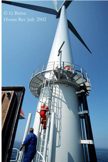
Figur 7-1 Plattform som vid stora våghöjder kan skadas.
