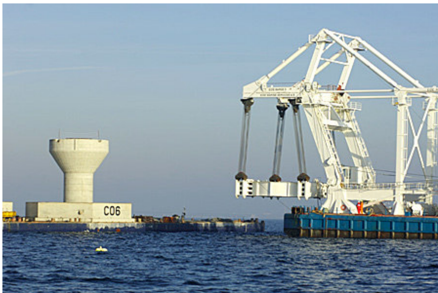
Figur 9-2 Eide Barge V i arbete på Lillgrund.
